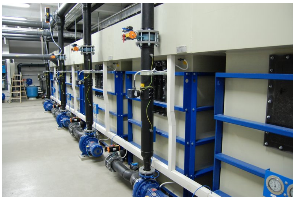
(Slika 1 - Captura® filtrirni sistem v Kempinski Palace, Slovenija s skupnim obtokom 272 m 3 /h, morska voda)
