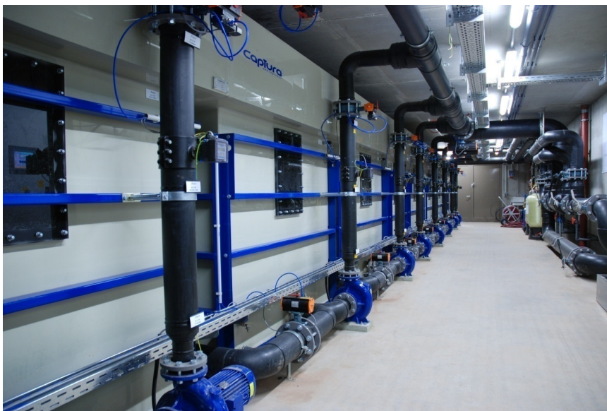
(Slika 9 - Capura® filtarski sistem v Freibad Hauenstein sa zajedničkim optokom 772 m 3 / h)
